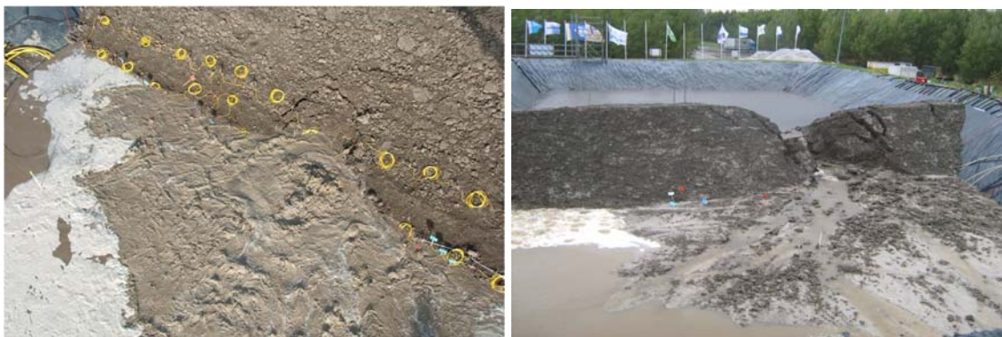
Abb. 10: Endphase: Zunahme des Sandtransports und des Durchflusses kurz vor Beginn des Deichbruchs (links) und der durchgebrochene Deich mit Breschenbildung (rechts)
