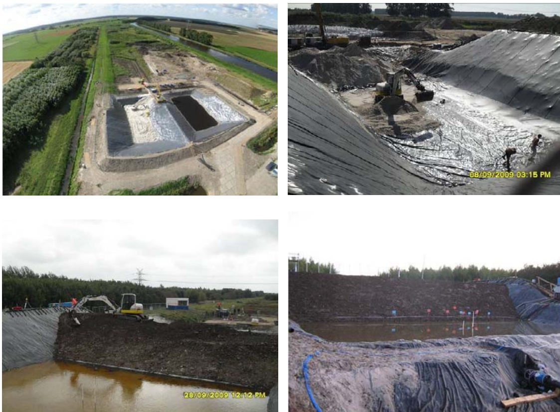
Abb. 6: Blick auf das IJkdijk-Versuchsgelände (links oben), Füllen eines der Bassins mit Sand (rechts oben), Errichtung des Kleideichs (links unten) und Blick auf die unterstromige Seite des Deichs (rechts unten)
