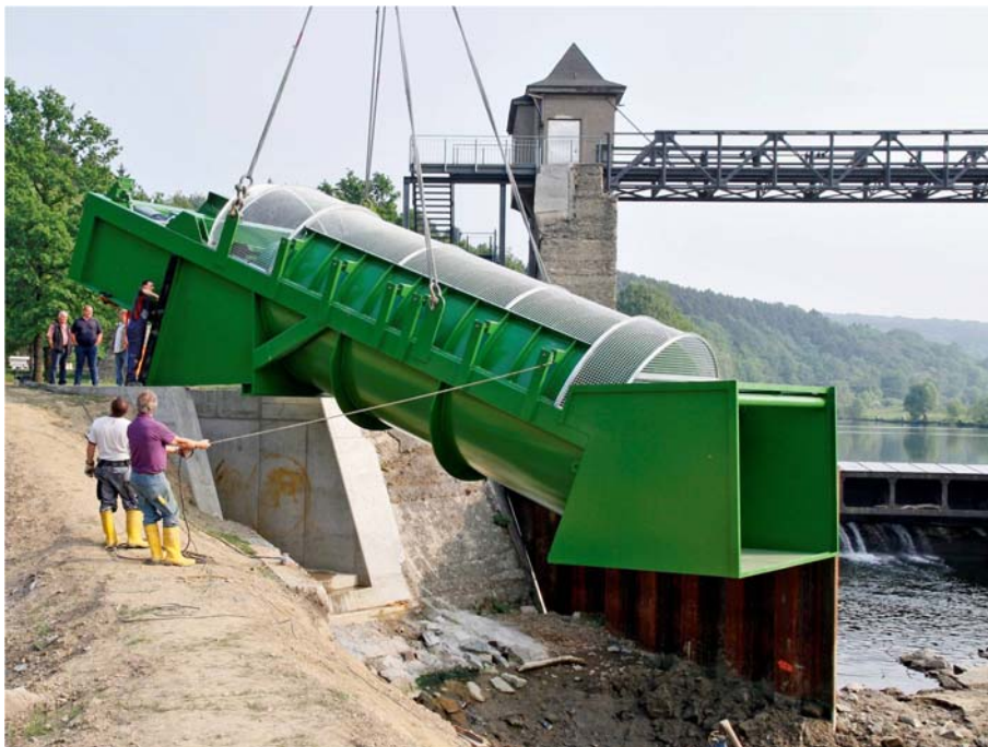
Abb. 7: Einsetzen der Restwasserschnecke am Wehr Wickete (Quelle: Jürgen Drees, Stadtwerke Fröndenberg GmbH)
