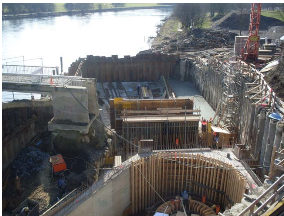
Abb. 2: Baustelle Wasserkraftwerk Kemnade (Quelle: Ulrich Moschner, Ruhrverband)
