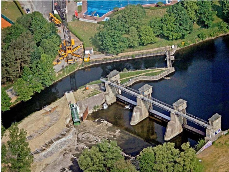
Abb. 6: Baustelle Wasserkraftwerke Wickete a.d.R., Wehranlage, Raugerinne-Beckenpass, Restwasserschnecke (Quelle: Jürgen Drees, Stadtwerke Fröndenberg GmbH)
