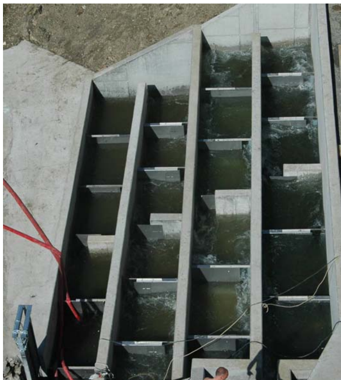
Abb. 4: Baustelle Fischaufstiegsanlage, Einsatz von Schlitzpass-Trennwänden aus Edelstahl (Quelle: Carsten Linneborn)
