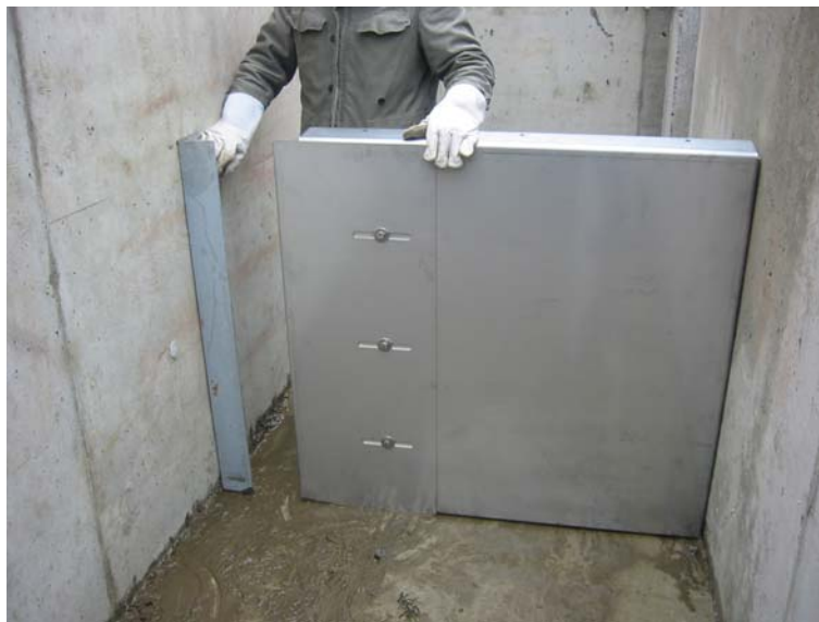
Abb. 3: Schlitzpass-Segment, Trennwand aus Edelstahl (Quelle: Carsten Linneborn)
