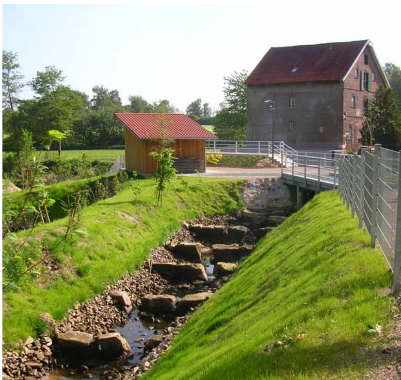
Abb. 5: Wasserkraftschnecke Alferts Mühle, Raugerinne-Beckenpass vor der Inbetriebnahme (Quelle: Flick Ingenieurgesellschaft GmbH)
