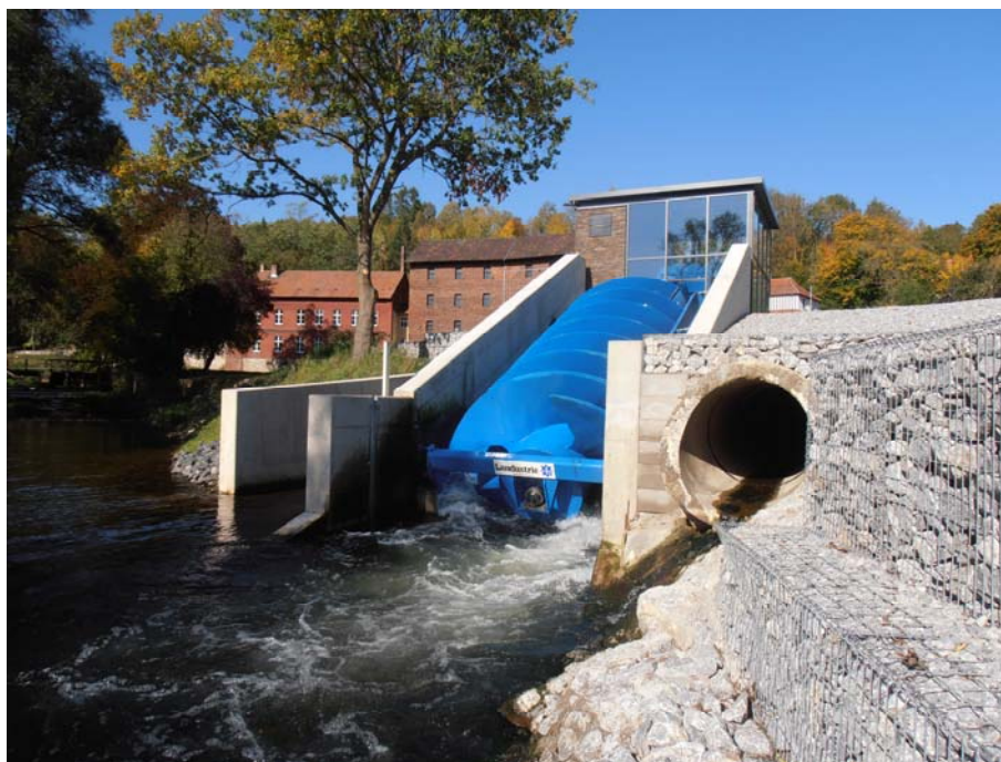
Abb. 8: Wasserkraftschnecke Kuhlemühle, Warburg (Quelle: Bernd Flach, AQUA HELICA GmbH)
