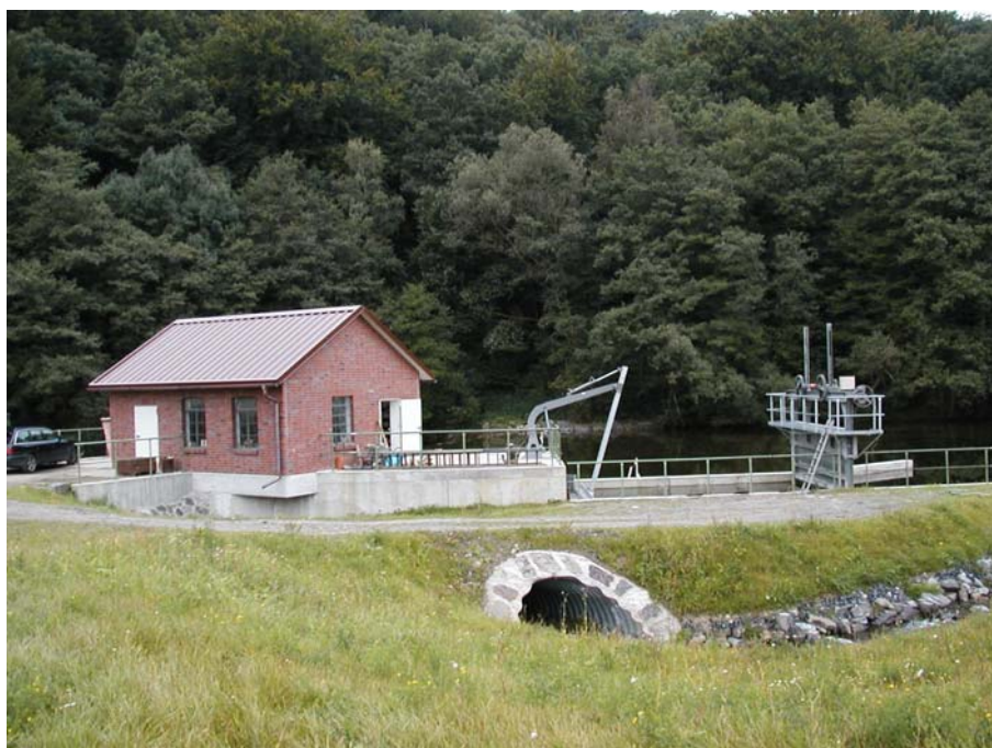
Abb. 1: Wasserkraftanlage Möhnebogen (Quelle: Thomas Kroll, Stadtwerke Arnsberg GmbH & Co. KG)
