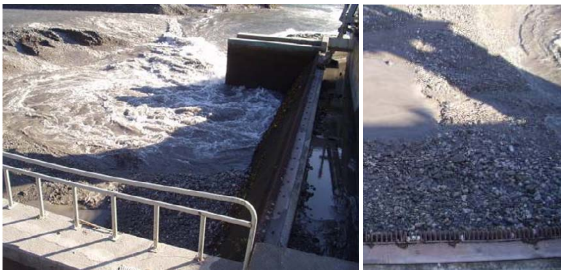
Abb. 13: Verlandung eines kompletten Rechenfeldes mit grobkörnigem Material
