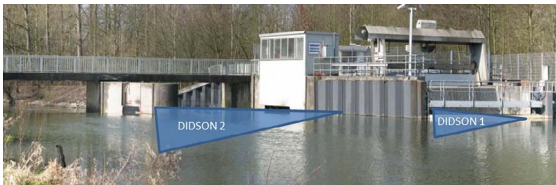
Abb. 9: Didson-Setup am Standort Hamm-Uentrop, hier parallele Datenerfassung an der WKA und am Wehr (BUGeFi, LFV Hydroakustik GmbH)
