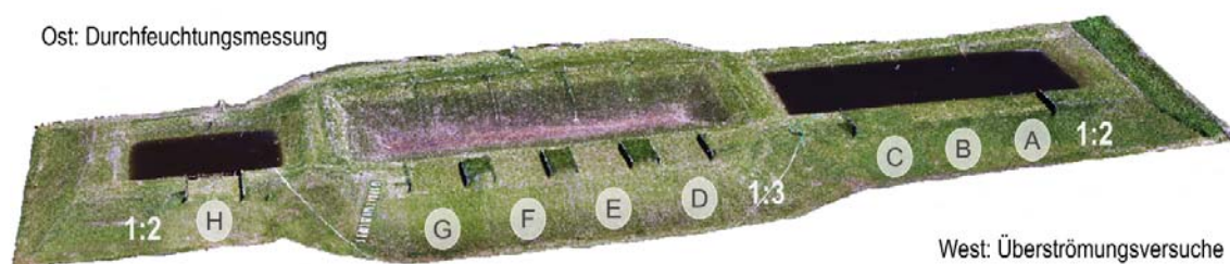
Abb. 1: Rostocker DredgDikes-Versuchsdeich, UAV-3D-Ansicht
