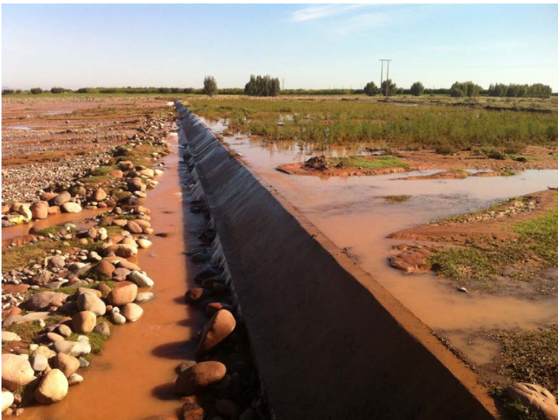
Abb. 2.2: Beispiel eines aufsedimentierten Stauraums hinter einer Sohlswelle in Marokko (Schüttrumpf, 2012)
