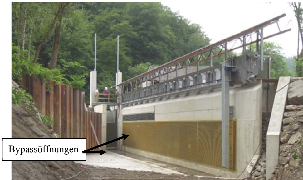
Abb. 9: Horizontalrechen (Bauphase), Stababstand = 12 mm (WKA Auerkotten / Wupper, Q_a = 14 \text{ m}^3/\text{s} ), Spülkanal und Bypassöffnung links neben dem Rechenfeld, zusätzlicher Bypass oberhalb des Rechens
