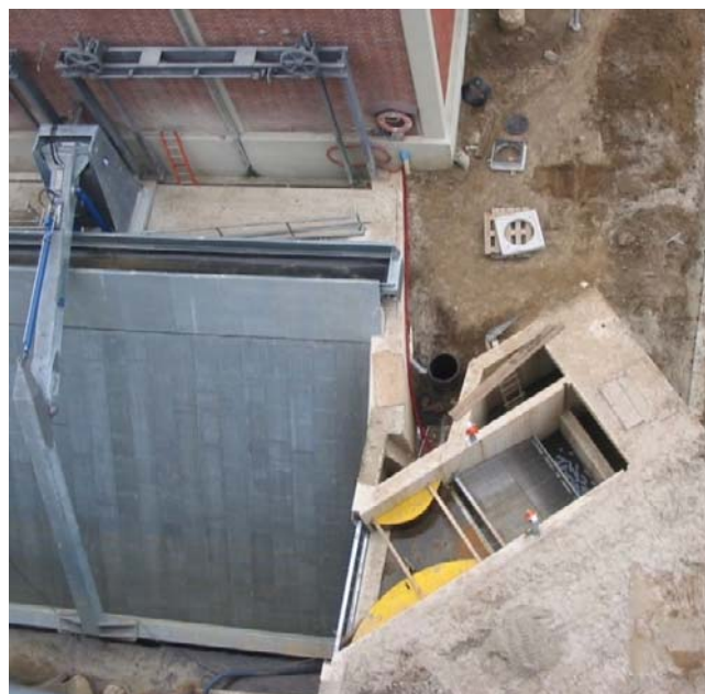
Abb. 10: Oberflächennaher Bypass für Lachssmolts (WKA Roeamond, NL,Rur)
