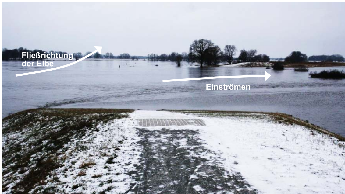
Abb. 3: Einströmen durch Schlitz 1 der Deichrückverlegung Lenzen am 18.01.2013 (Abfluss > MHQ; Bildquelle: M. Promny, BfG)
