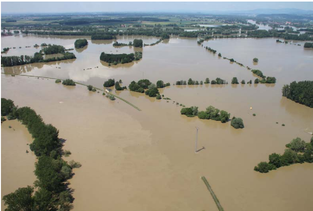
Abb. 5: Deichbruchstelle bei Auterwörth
