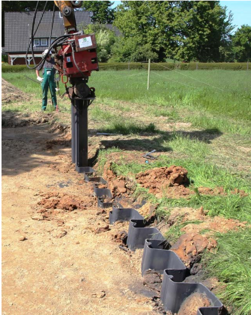
Abb. 8: Partiieller Bodenaustausch mit Kunststoffspundwand (Quelle EWE Netz GmbH)
