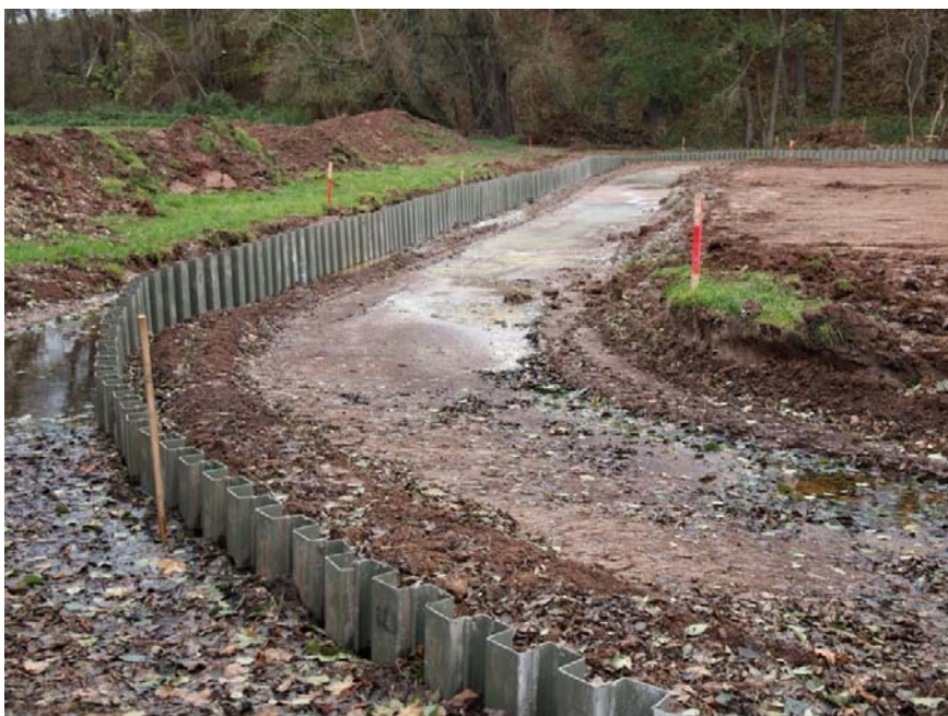
Abb. 6: Fertiggestellte Kunststoffspundwand
