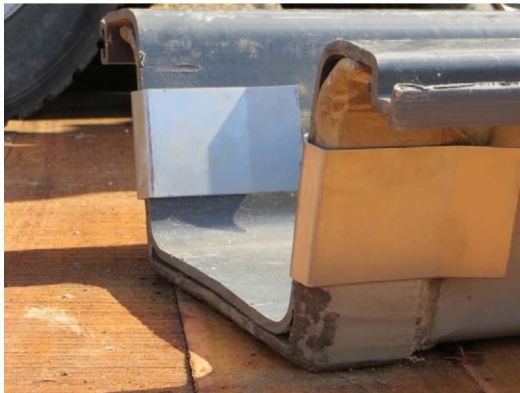
Abb. 3: Mitlaufende Mutterbohle und Stahlklammern
