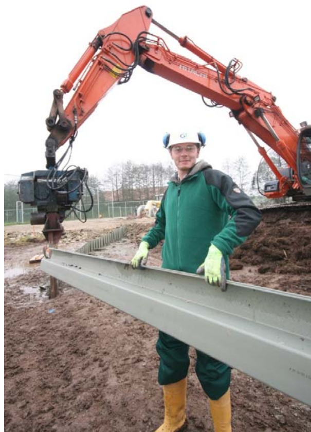
Abb. 1: Einfache Handhabung der Kunststoffbohlen auf der Baustelle
