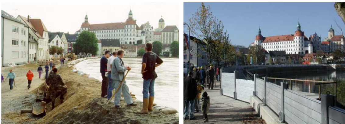
Abb. 6: Donau, Neuburg an der Donau, 1999 ohne und 2013 mit mobilem Hochwasserschutzsystem
