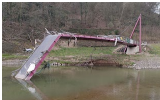
Abb.: Zerstörte Radbrücke in Mayschoß nach dem Hochwasser 2021 (Quelle: IWW)
